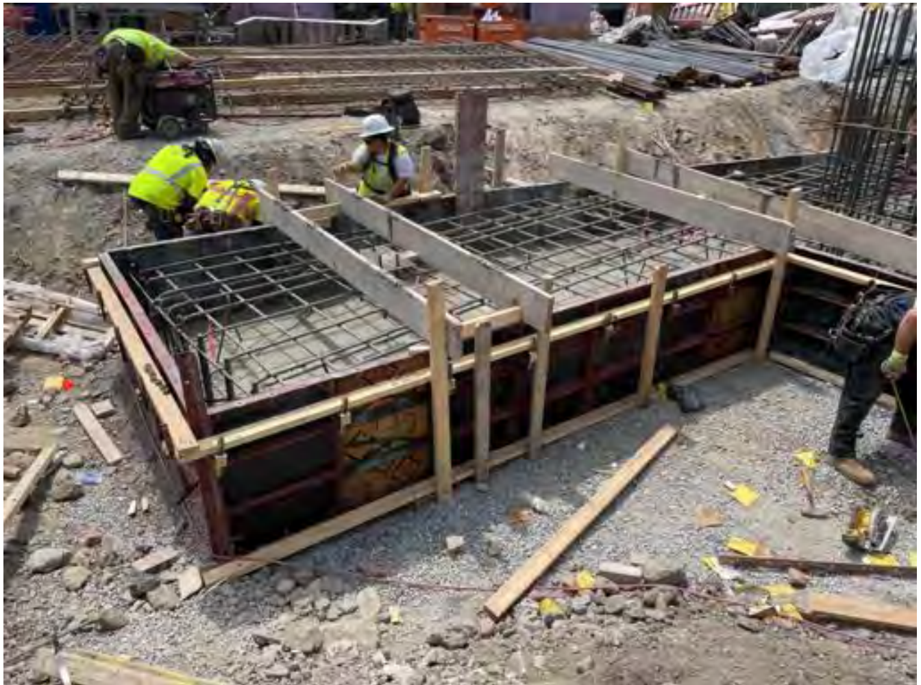
Concrete pour, mat slab B.
