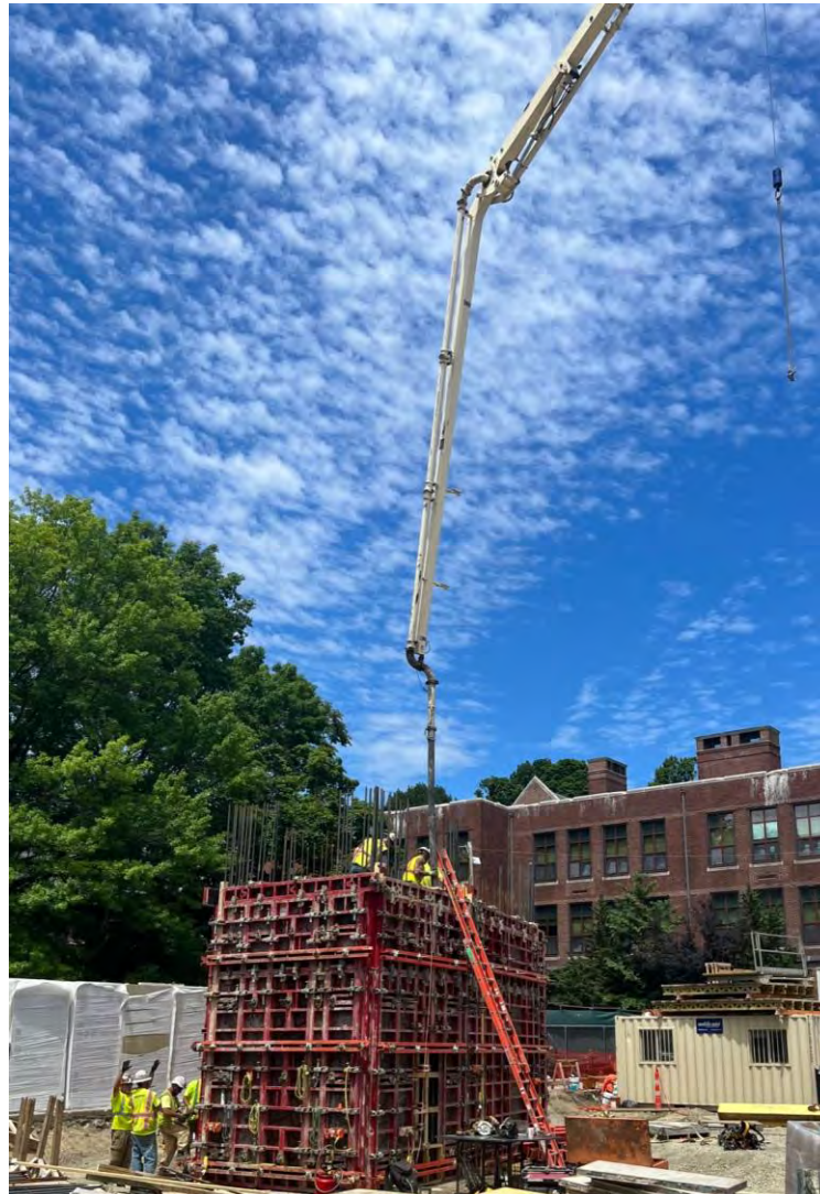
Core B level 1 concrete pour
